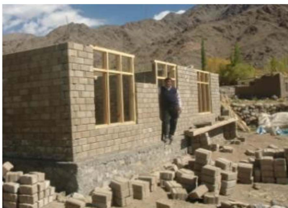
प्लेट 6: ल्हासा में घर: स्थिरीकरण करने वाली सामग्रियों जैसे सीमेंट/चूना का उपयोग करके स्थानीय मिट्टी से निर्मित आवास
